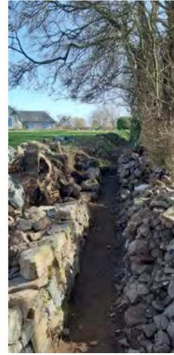
Fig. 9 & 10. Le mur totalement reconstruit aura une longueur totale d'environ 60 m et fait 1,70 m dans sa plus grande hauteur.
