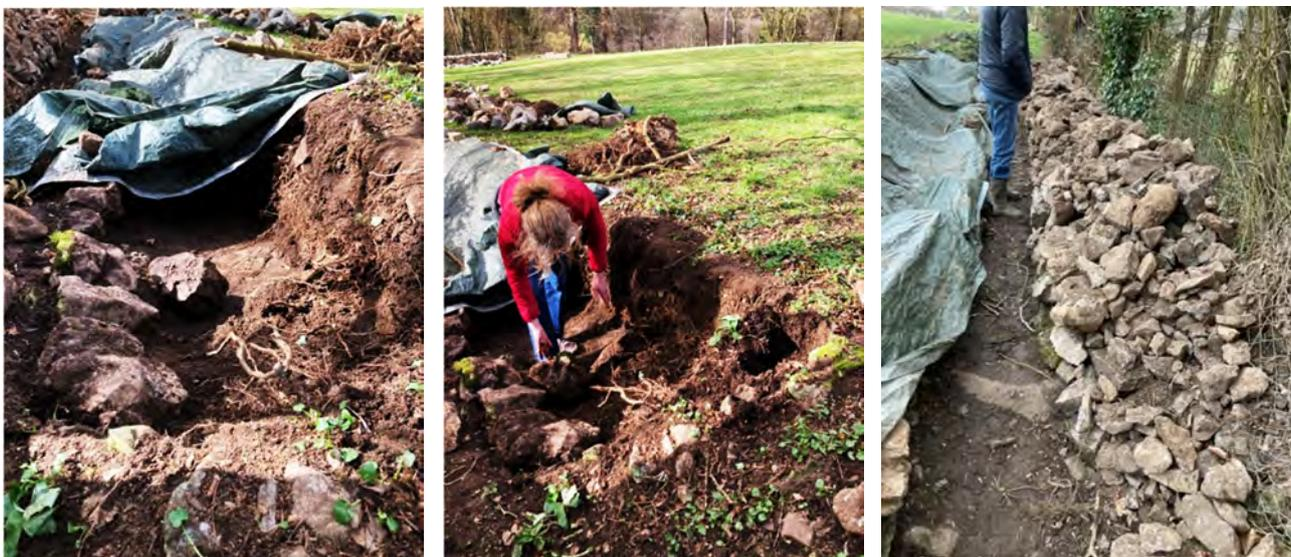
Fig. 3 à 5. Les pierres ont été retirées du talus et rassemblées de l'autre côté du sentier. Ensuite le terrain a été préparé pour recevoir le mur : terrassement du sol et verticalisation du côté. © F. ANDRÉ-DUMONT.
