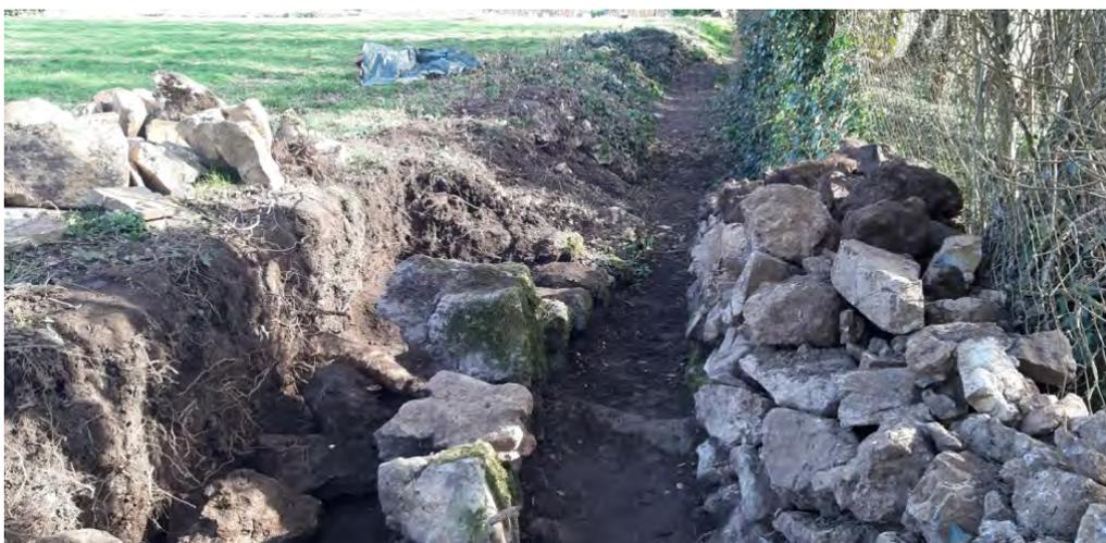
Fig. 8. À gauche, la face avant du mur en construction et l'espace préparé par Ariane pour la construction de la face arrière. À droite, les pierres qu'elle a retirées du talus. © A. VAN DOOSSELAERE.
