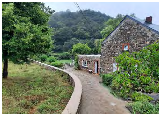
Fig. 22. Vers 15 h, le Ry de Vesse lèche toujours le pignon du n°15.
