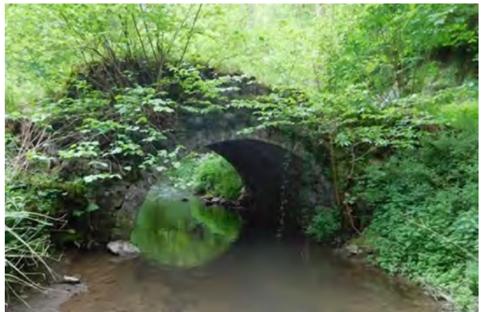
Fig. 45. Pont de la Vierge avant juillet 2021.
