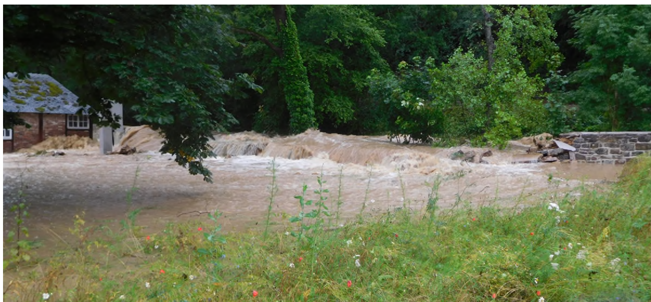
Fig. 24. Le mur d'enceinte du château vers 7 h, peu de temps après son effondrement.
