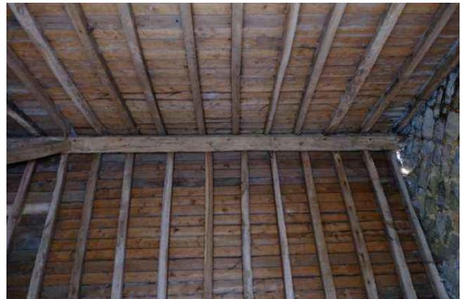
Fig. 9. & 10. Quelle belle charpente que celle du garage mutilé par une façade en parpaings. Mais... le jour visible au pignon (Fig. 10, à droite) montre que dans un temps pas si lointain, sans intervention, celui-ci croulera aussi. © M. VAN DEN BOGAERT.
