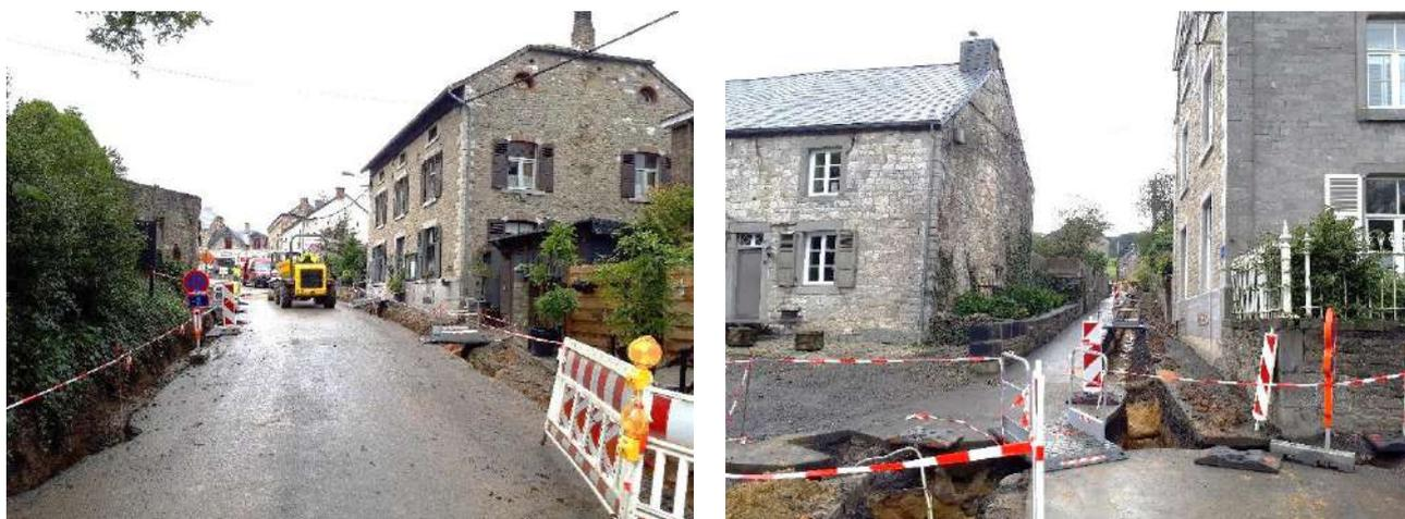
Fig. 6 et 7. L'ouverture des tranchées destinées à accueillir les câbles électriques et les tuyaux d'évacuation des eaux pluviales. © H. Labar, 27.09.2022.
