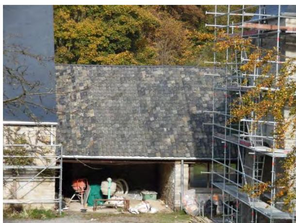
Fig. 9 & 10. L'auvent recouvert de tuiles neuves côté jardin et de tuiles récupérées côté cour. © H. Labar 23.10.2016.
