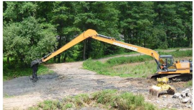
Fig. 15 & 16. Le curage des douves et le transfert des boues. © H. Labar 07.07.2016.
