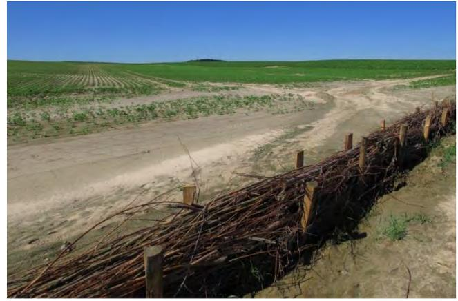
Fig. 4 & 5. Implantation de fascines de branchages. A droite, on mesure l'efficacité du dispositif.
