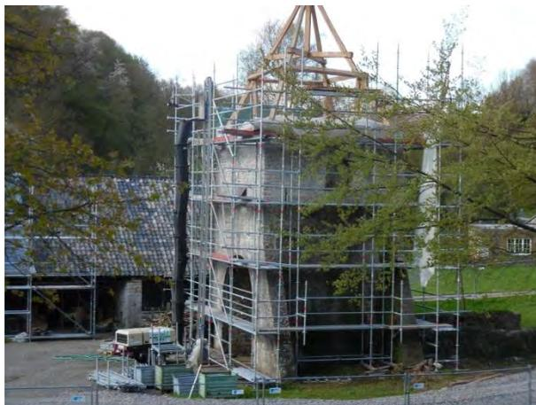
Fig. 5 & 6. Les premiers travaux au porche : placement des échafaudages et enlèvement de l'ancienne toiture.
