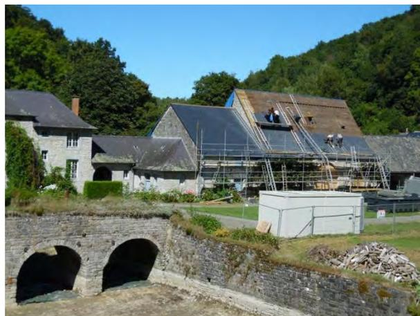
Fig. 7 & 8. Les travaux se poursuivent avec la rénovation de la toiture de la grange. L'auvent attenant est déjà recouvert de tuiles. © H. Labar 07.07.2016 & 24.08.2016.
