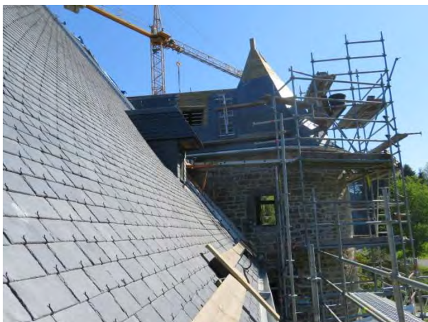
Fig. 10. Un travail d'ardoisier particulièrement difficile : raccorder une toiture octogonale sur un mur circulaire.
