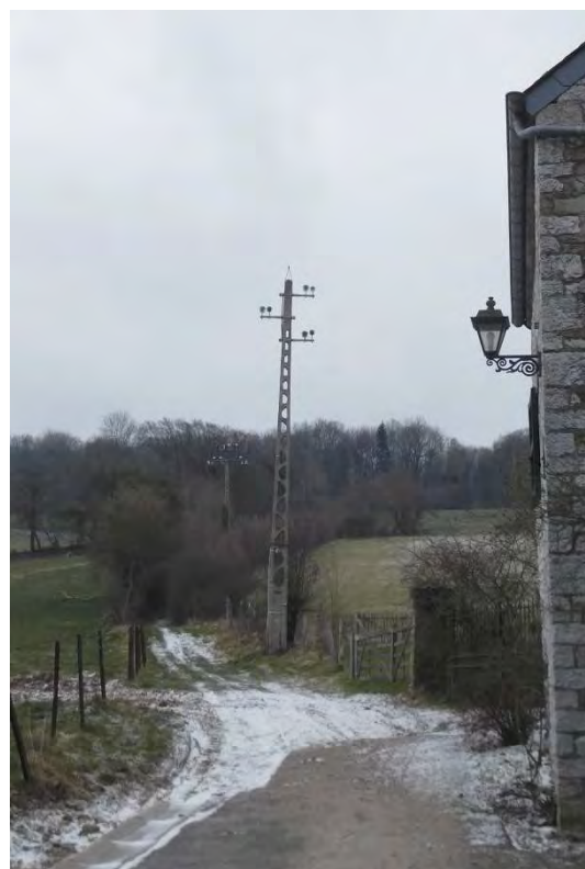
Fig. 4. Le chemin creux qui grimpe vers Durnal ainsi que les poteaux électriques sans câble (Fév. 2018, © P. André).
