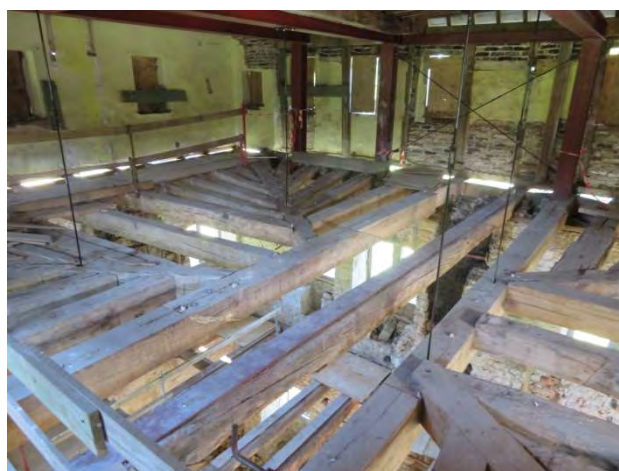
Fig. 8 & 9. Le plancher du 3 e étage, en arrêtes de poisson, et les portiques et tirants le soutenant (06.05.2018, © H. Labar).
