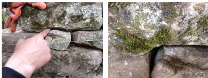
Il arrive qu'on doive couper une petite saillie dans la pierre (photo) et on ajoute des cales qui comblent les creux éventuels entre deux couches. On a préparé, pour ce faire, une collection de petites pierres dans laquelle on sélectionne par essais et erreurs celle qui comblera la cavité le mieux possible et n'en dépassera pas. Pour faire des cales, on casse des pierres qui ne sont pas spécialement intéressantes pour la construction du mur. Enfin, toutes les pierres doivent se toucher.
