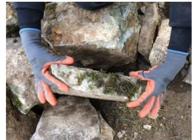
Fig. 21 à 23. Sélectionner la pierre de parement et choisir la face avant, la plus rectangulaire possible.
