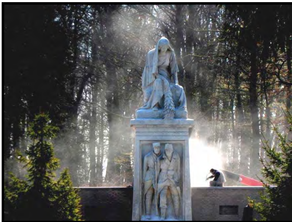
Le monument principal en cours de rénovation en mars 2014. (© Freddy Bernier)
