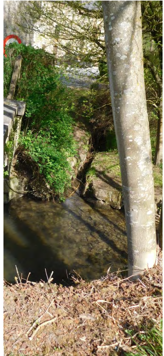
Figure 5, Le canal de dérivation de l'ancienne papeterie;© ANDRE P. 2019.
