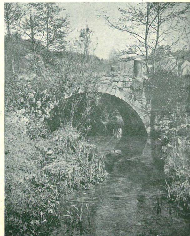
Vieux pont sur le Crupet.
