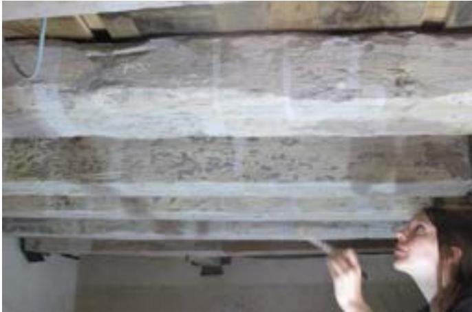
Le papier Lens tissue, papier fin, de ph neutre a été encollé à la colle tylose à 3 % et posé sur l'entièreté des poutres beiges, bas et flancs de poutre et sur la zone noire dite enfumée, uniquement sur le bas des poutres.
