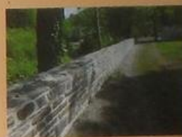
La mise en œuvre de calottes de protection étanches sur les murets d'enceinte en moellons
