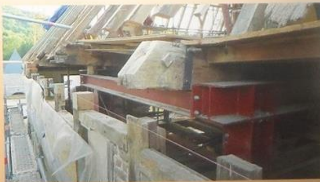
La fabrication et la pose de la structure métallique de consolidation de la charpente du donjon
