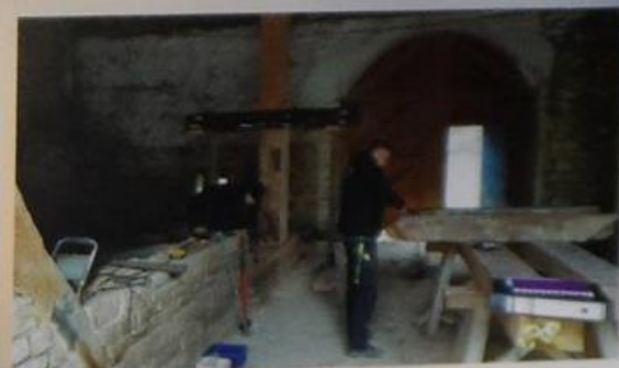
Les travaux de restauration de maçonneries
