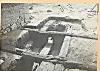
DECOUVERTE DE L'ANCIEN PONT-LEVIS AU FOND DES DOUVES
